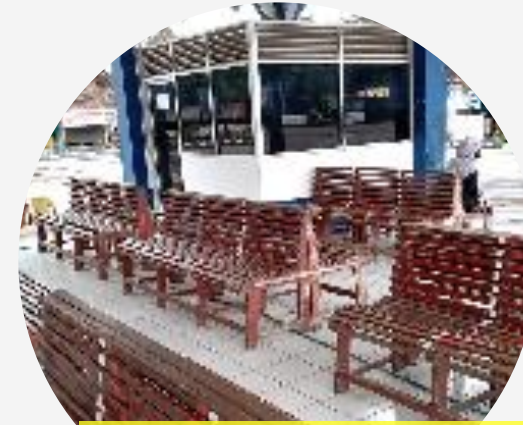
RUANG TUNGGU PENUMPANG
