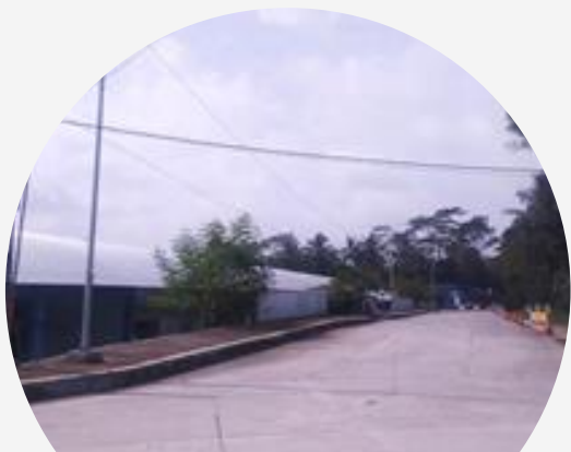
PINTU MASUK TERMINAL
