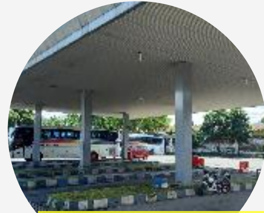
RUANG TUNGGU PENUMPANG
